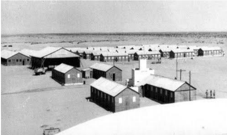
Panorámica del B.I.R desde el depósito de agua.- (1968)
